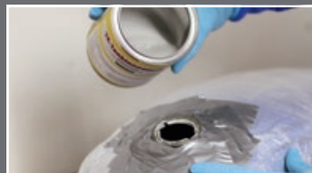
Ist der Tank innen sauber, wird der zwei-Komponenten-Beschichtungslack eingefüllt.
